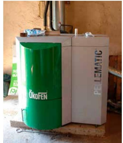
*La chaudière Ökofen de 20 kW est alimentée par une vis sans fin reliée à un silo textile de 4 tonnes. Deux grands ballons tampons permettent d'optimiser entre consommation d'eau chaude et chauffage, apports solaires et apports en granulés. Les panneaux sont situés plein sud et adroitement masqués par un mur de la propriété. Une installation 100% renouvelable en harmonie avec l'esprit de la Tour d'Auzay.*
