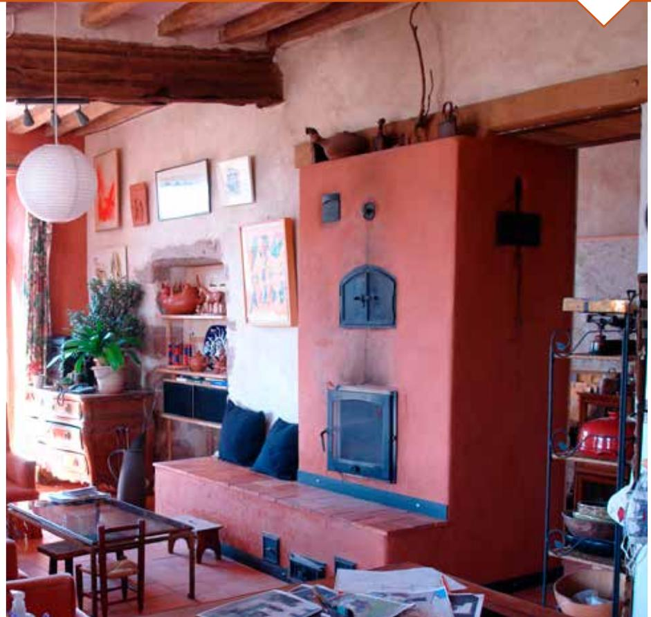
Le poêle de masse Debriel, chauffage principal de la première partie de la maison. Il chauffe par rayonnement et par un circuit d'eau qui alimente un plancher chauffant et un radiateur et suffit presque à chauffer les 247 m<sup>2</sup> !
