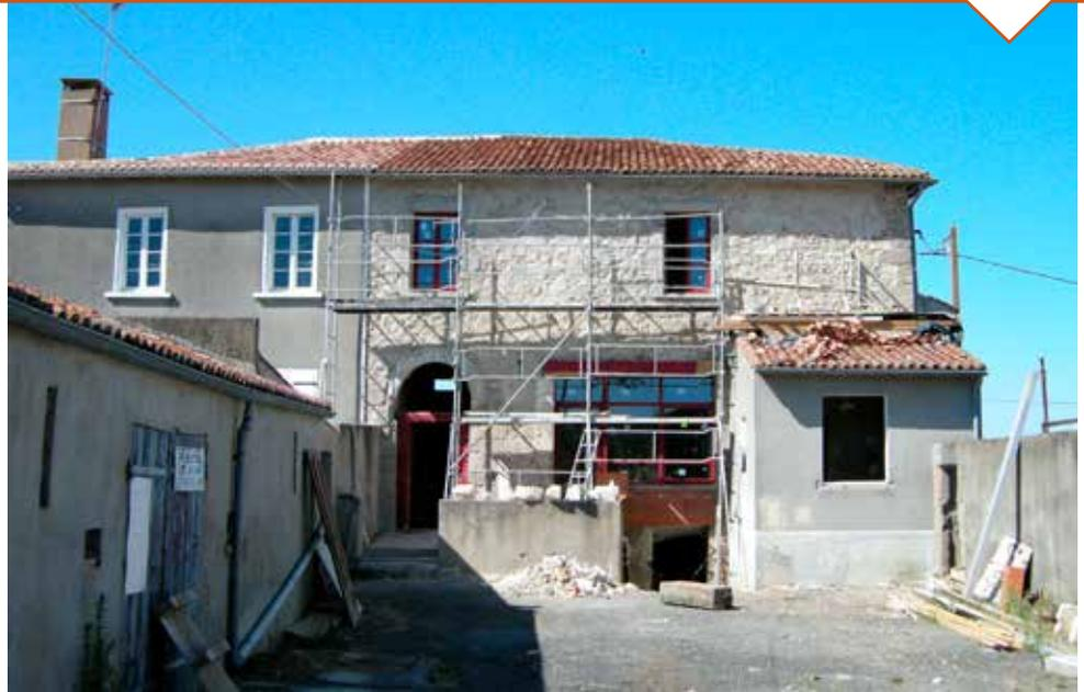
*Les enduits ciment démontés, la pierre peut à nouveau respirer. D'anciennes ouvertures sont réouvertes, d'autres créées. Un travail magnifique commun au maçon et au menuisier.*
